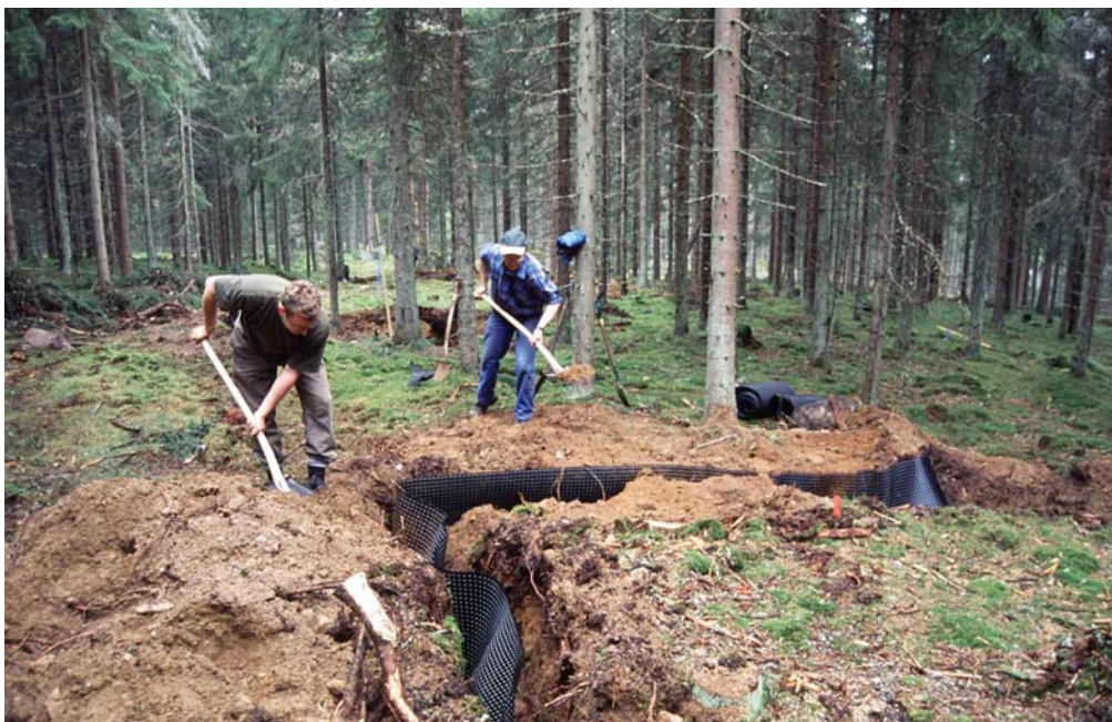
Figur 2. Plastbarriär grävs ned för att avskärma från mykorrhizasvampar.
