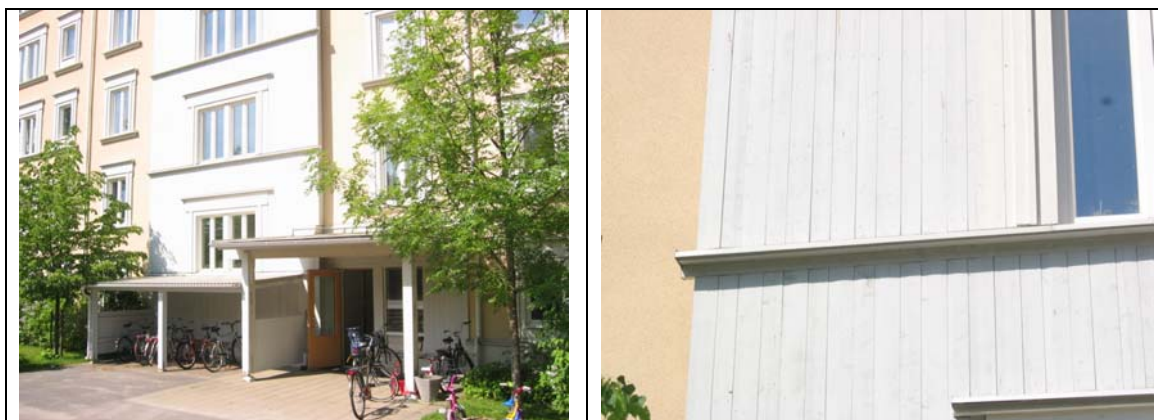
Figur 9. Hus 1 bild på fasaden från våren 2006. Detaljbild på övergången mellan olika våningsplan. Foto Finn Englund SP-Träteck.
